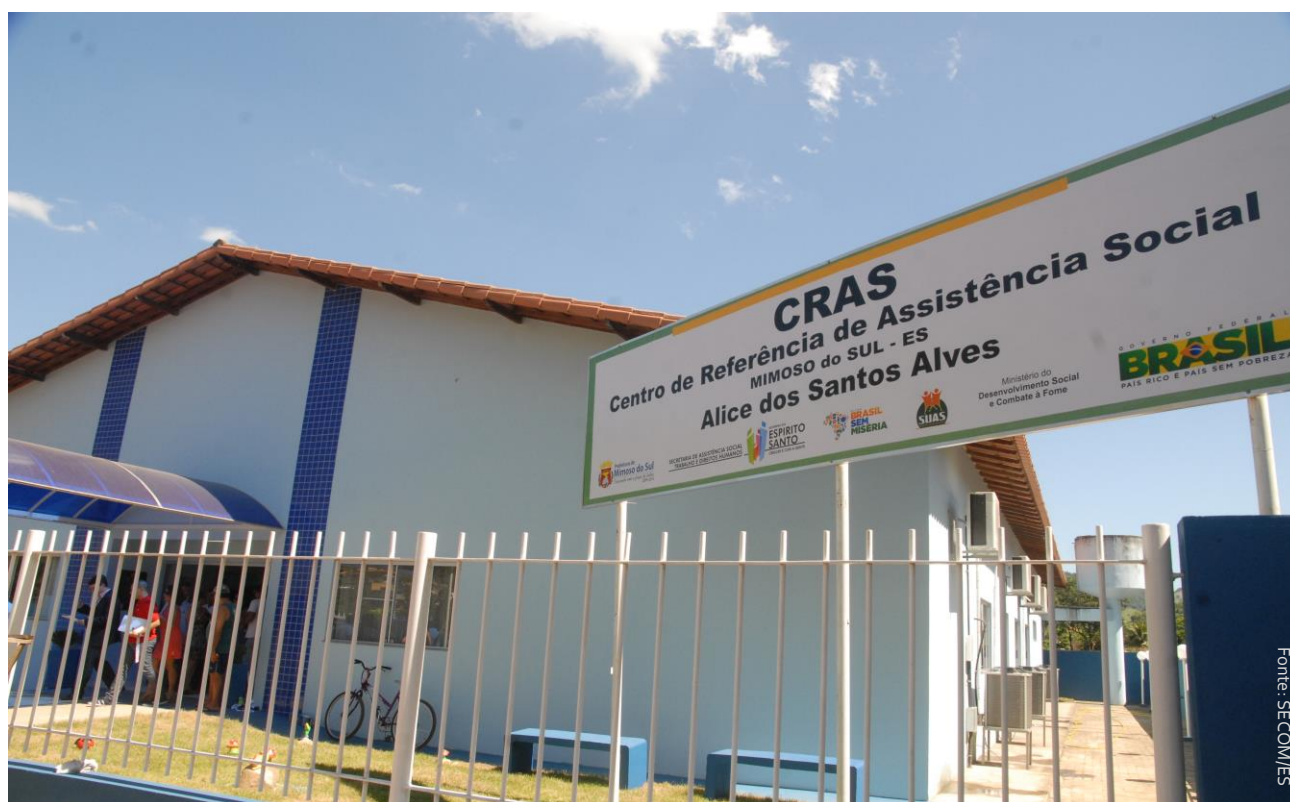
CRAS construído em Mimoso do Sul
