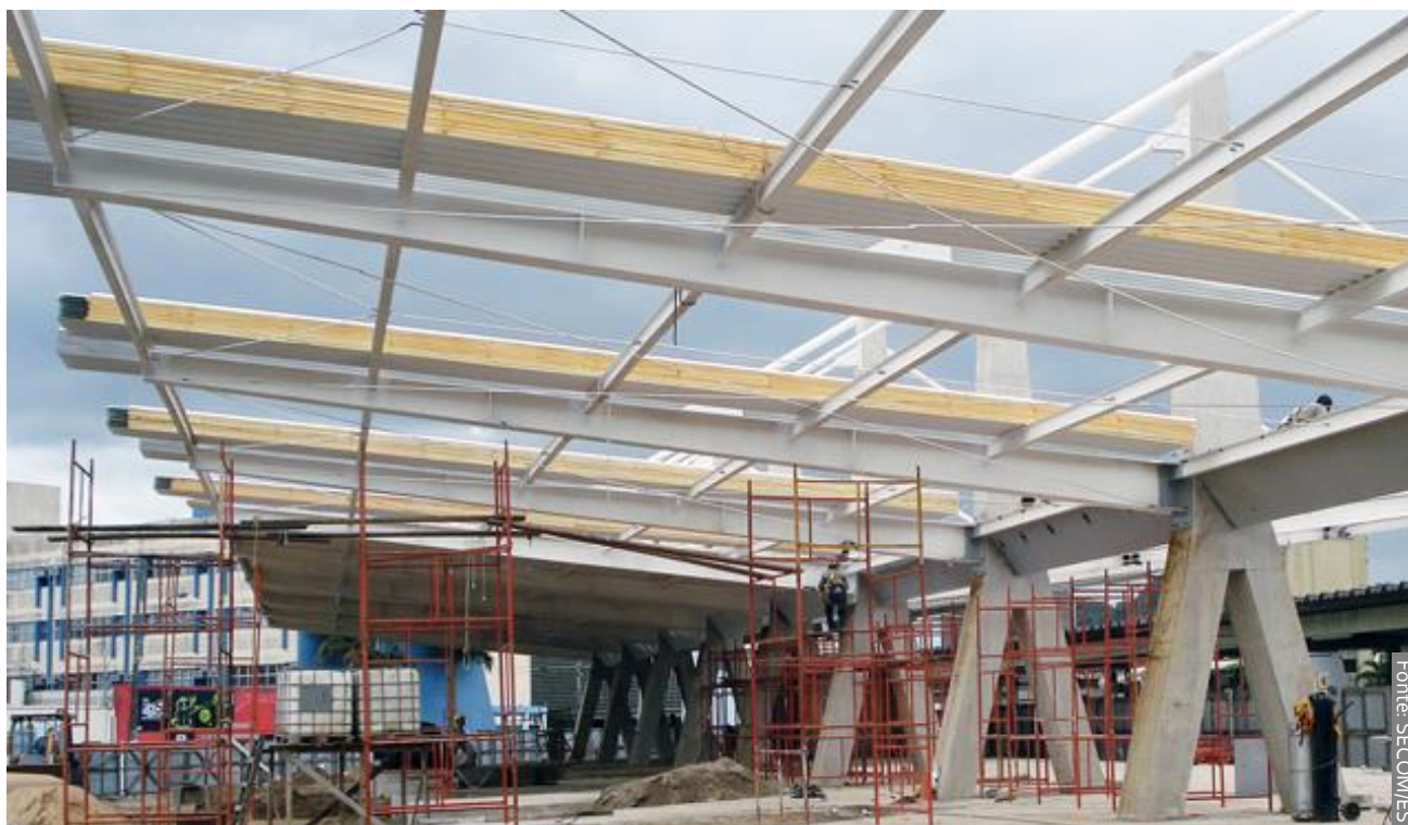
Novo Terminal de Vila Velha
