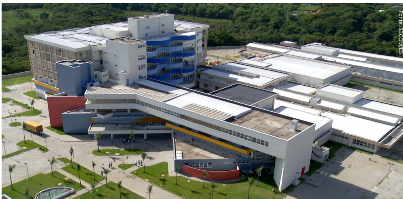
Construção do Hospital Dr. Jayme dos Santos Neves
